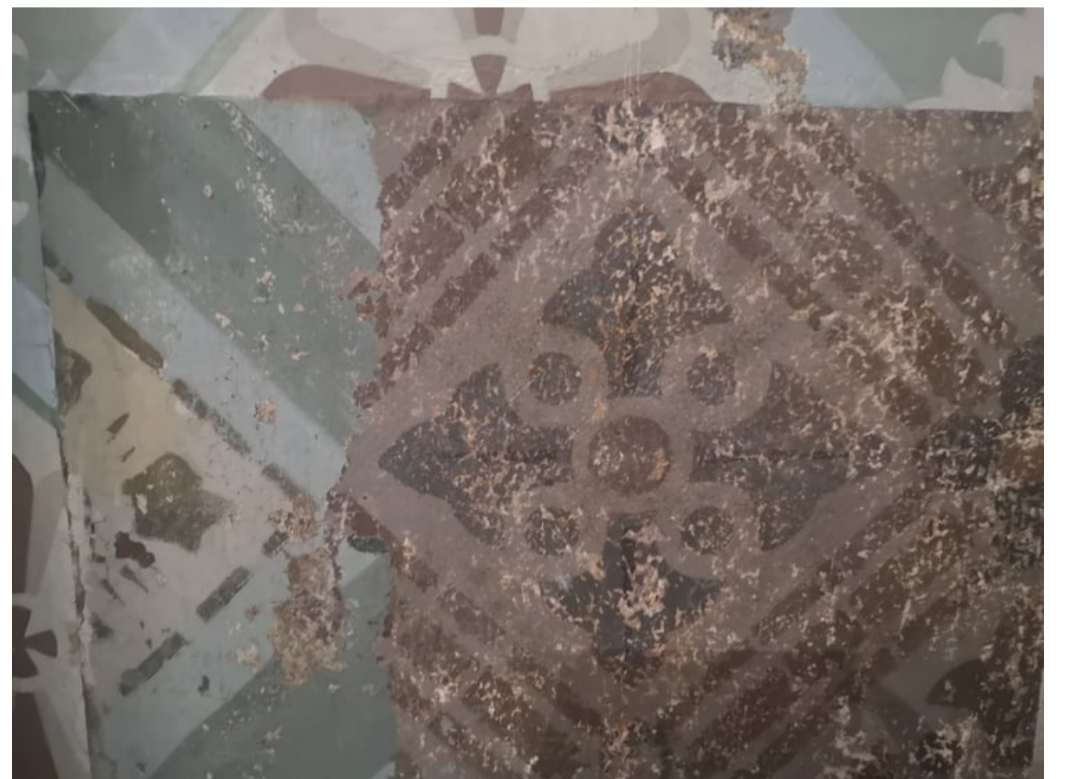
Bažnyčios sienų dažymo pavyzdžiai. Pro tamsiai pilką piešinį prasišviečia oranžiniai dažai: ankstyviausia sienų puošyba. Tada sekė tamsūs piešiniai, ant jo pieštas kiek šviesesnis, ant šio – dabartinis.
