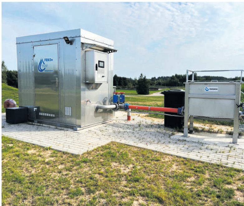
Valyklos teritorijoje įrengtas atvežtinių nuotekų priėmimo mazgas.
