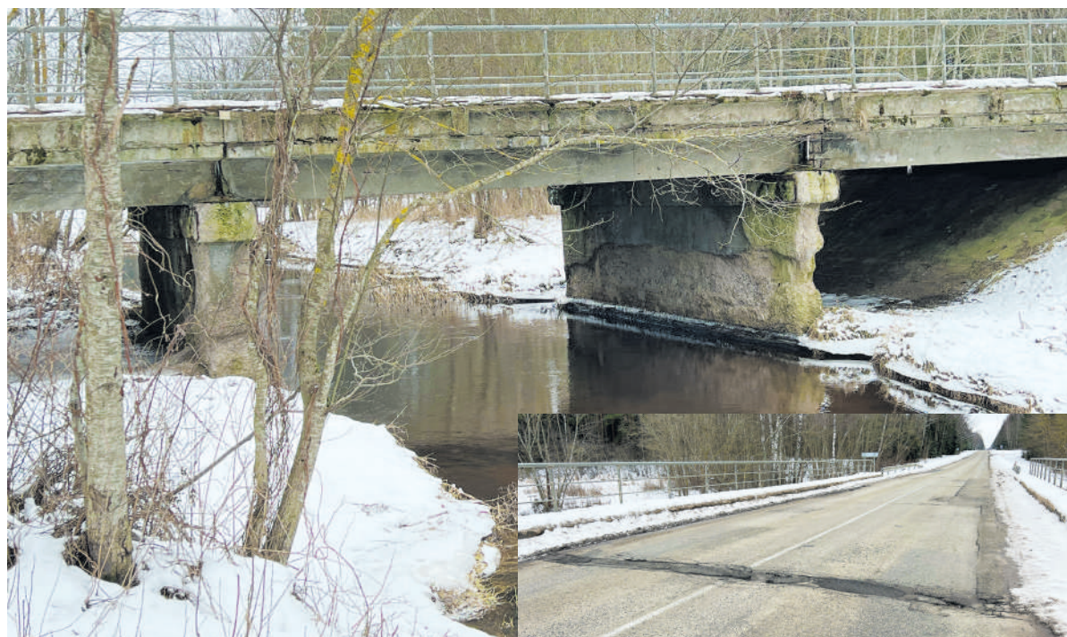
Tiltas per Nemunėlį – vienas prasčiausių Rokiškio rajone, plika akimi matomi įtrūkimai ir jų „užlopymai“. („Rokiškio Sirenos“ nuotr.)
