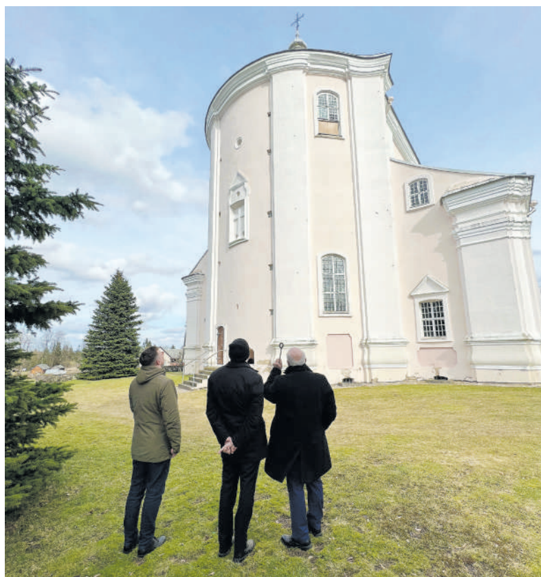
Bažnyčios išorė prašyte prašosi remonto.
